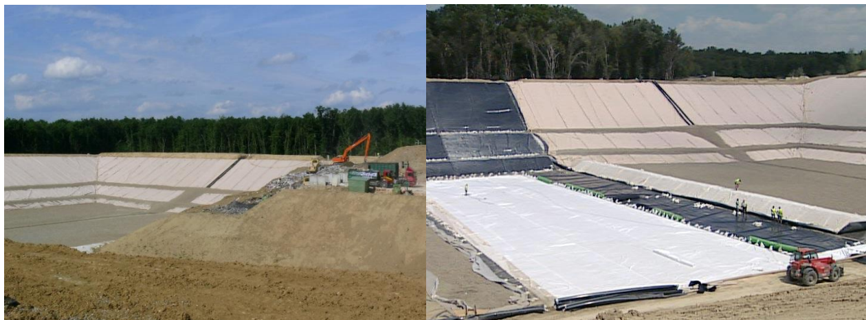
Centre de Stockage des Déchets Ultimes avec valorisation énergétique, Alvéoles en cours de fabrication puis de remplissage (DRIMM, Montech 82). Alvéoles de Stockage des Déchets Ultimes en cours de construction.
